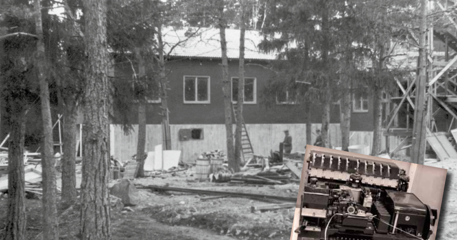
Byggnadsarbeten vid FRA:s anläggning på Lovön 1943. Bild till höger: Tysk G-skrivare.
