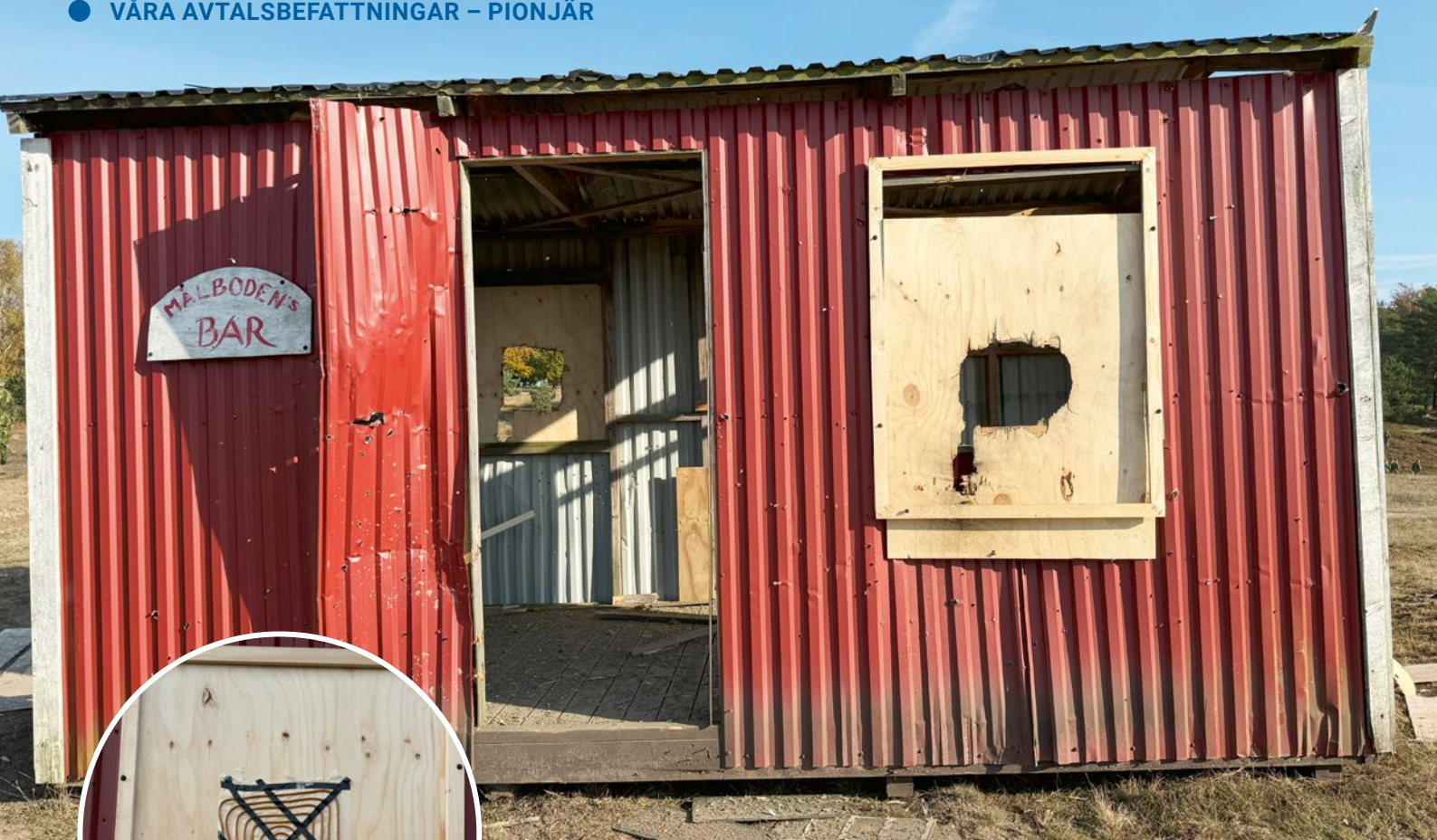
Pionjärsoldaterna fick lära sig att spränga bort dörrar och fönster för att kunna forcera byggnader. Här har man använt en fyrkantsladdning med pentylstubin.
