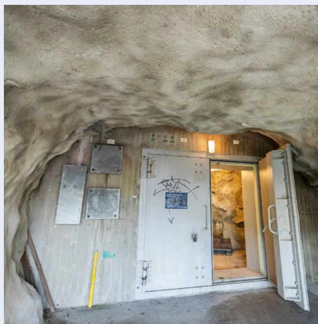
Skyddsrum. Foto: MSB
