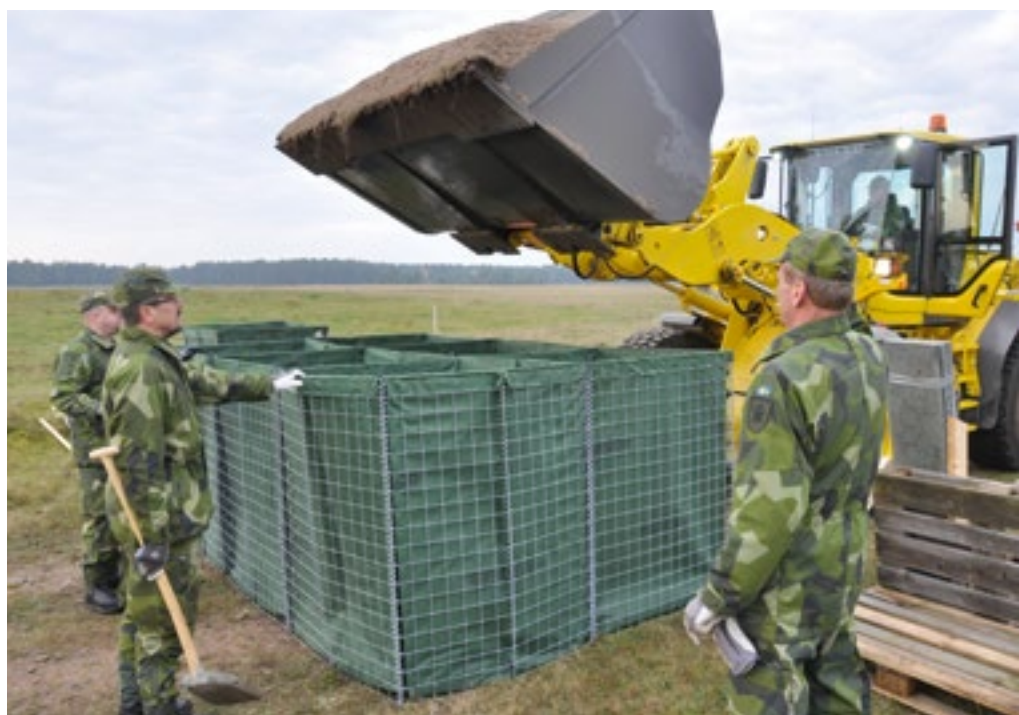
Bygge av en sk Hesco bastion, ett skydd som används runt militära camper, men också för att förebygga översvämningar.
